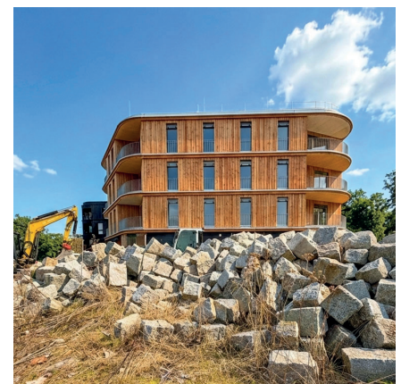
Die Baustelle im Februar 2026
