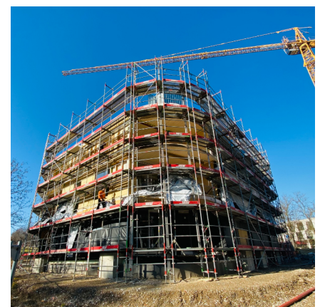
Die Baustelle im Januar 2025
